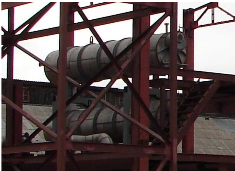
Монтаж горизонтального двухкорпусного дезодоратора г. Новохоперск, 2012 г.
